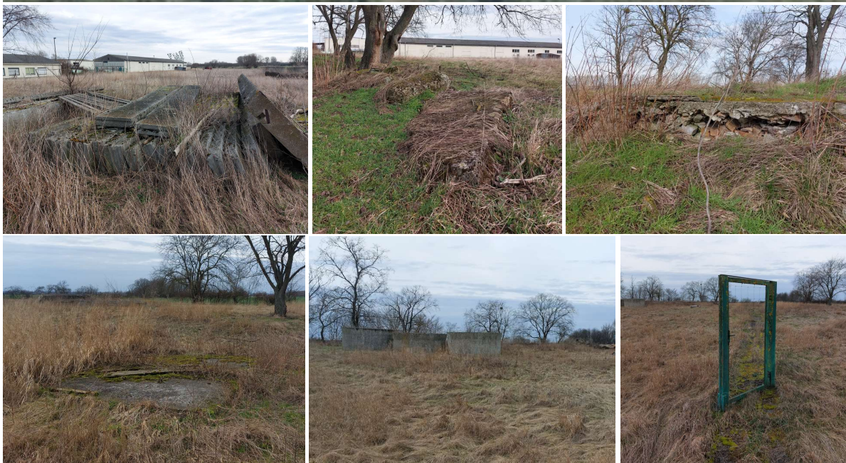
Abbildung 5: Versiegelte Flächen im westlichen Planungsgebiet (Haufwerke von Beton (63m 2 ), Gebäudefundamente (315m 2 ), Betonflächen am Gebäudefundament (57m 2 ), Betonringe, (34m 2 ), Betonweg mit freistehendem Toren (55m 2 )
